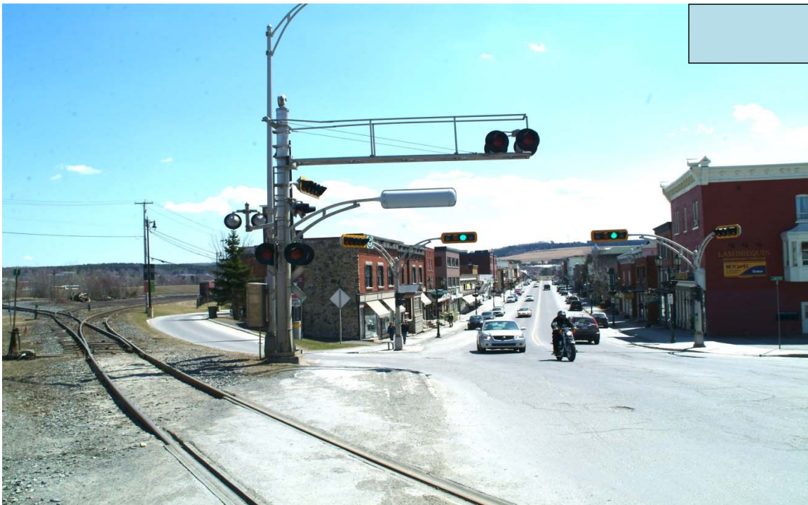
Figure 12: Section de voie avec courbe, aiguillage et défauts causés par des joints de rail affaiblis
